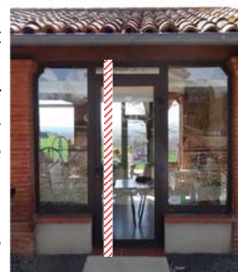
Après élargissement de 10 cm...
